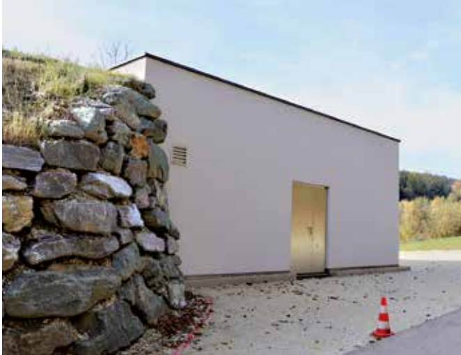
Der neue Hochbehälter am Wagner Kreuz.
