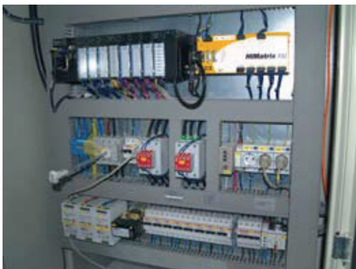
Blick in den Schaltschrank: Steuerungen GE+HIMA.
