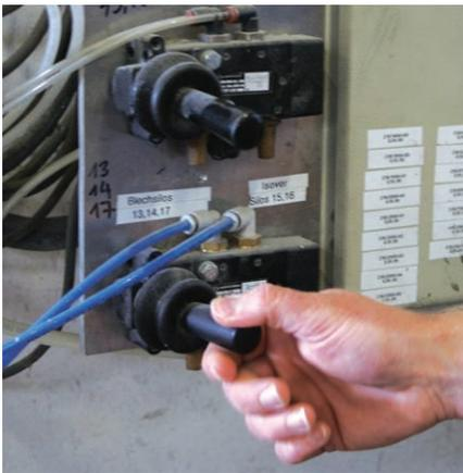
**Vorher:** Alte Silosteuerung mit manuell zu bedienenden Luftschalthebeln.
